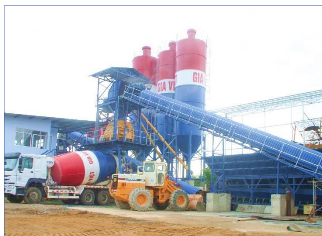
➤ Bê tông thương phẩm Fresh concrete
