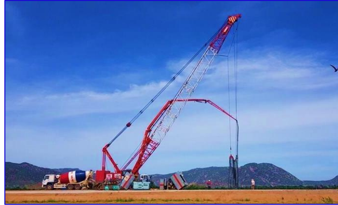
➤ Dự án cọc gia cố nền Piling Projects
